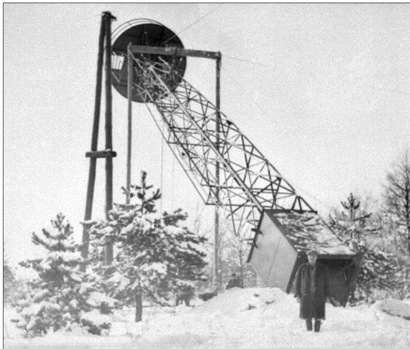
Stavba leteckého světelného majáku na kopci Hády u Brna. Ten byl postaven dříve než celá noční trať Praha – Brno – Bratislava (proto je odlišné konstrukce), do níž byl dodatečně zakomponován. Foto z pozůstalosti Jana Krumbacha, uloženo v TMB jako „Letecká doprava v ČSR II“ (18.00-03472)
