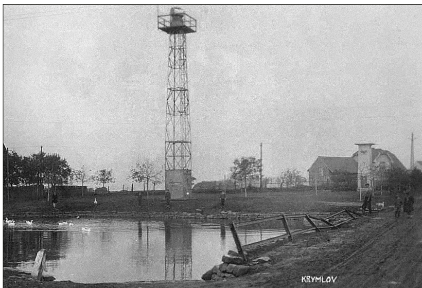
Dva pohledy na letecký maják číslo 2 postavený u obce Krymlov Foto archiv Ing. Bořivoje Čecha, http://www.vrtulnik.cz/ww2/tratove_majaky.htm
